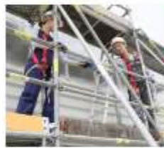
*Punto de anclaje correcto, cuerda de seguridad y arnés.
