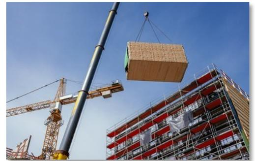
Todas las cargas también deben inspeccionarse antes de levantarlas para asegurarse de que se hayan retirado todos los artículos no usados, como madera, bandas de envoltura, herramientas y escombros. Estos elementos pueden olvidarse fácilmente y convertirse en objetos caídos.
